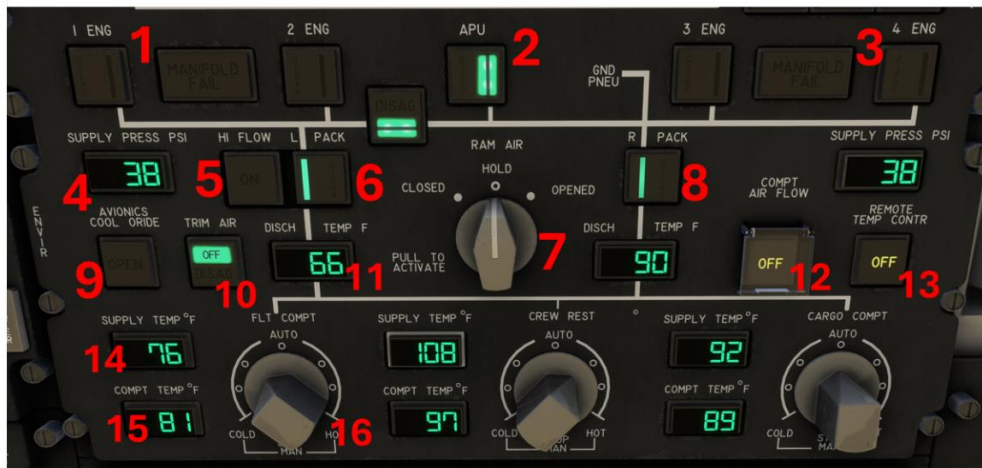
Bleed Air Supply / Air Con Panel
